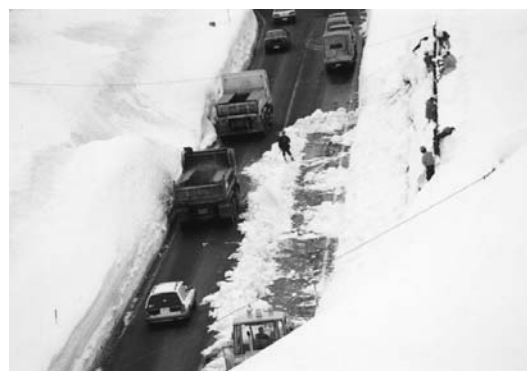
雪庇の除去作業
