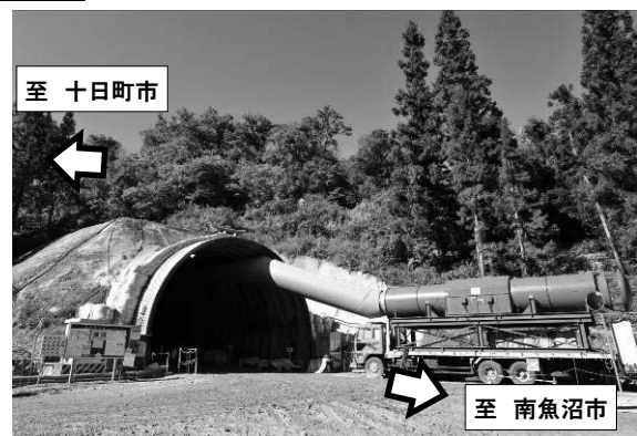
工事が進む八箇峠トンネル(仮称)
