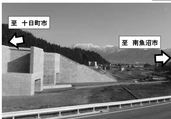
完成している橋梁下部
